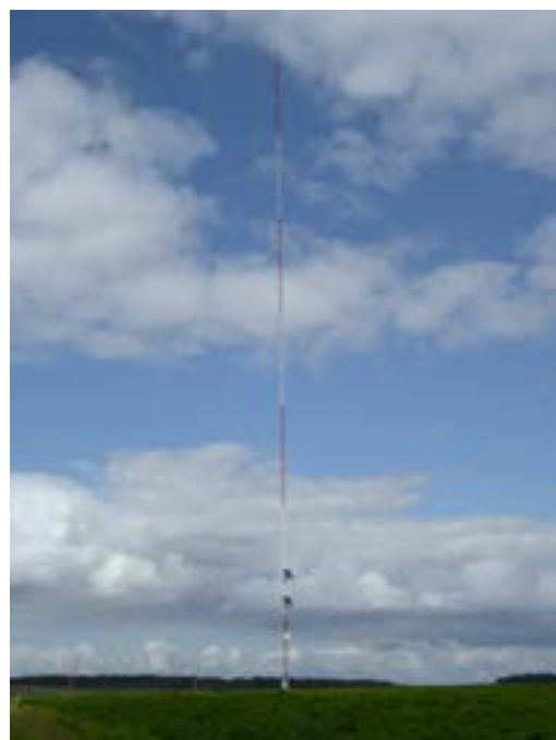
Mât de mesure du vent installé sur site
